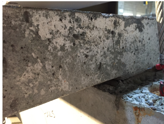
(d) PTB1-3 Close up of Interface Delamination
