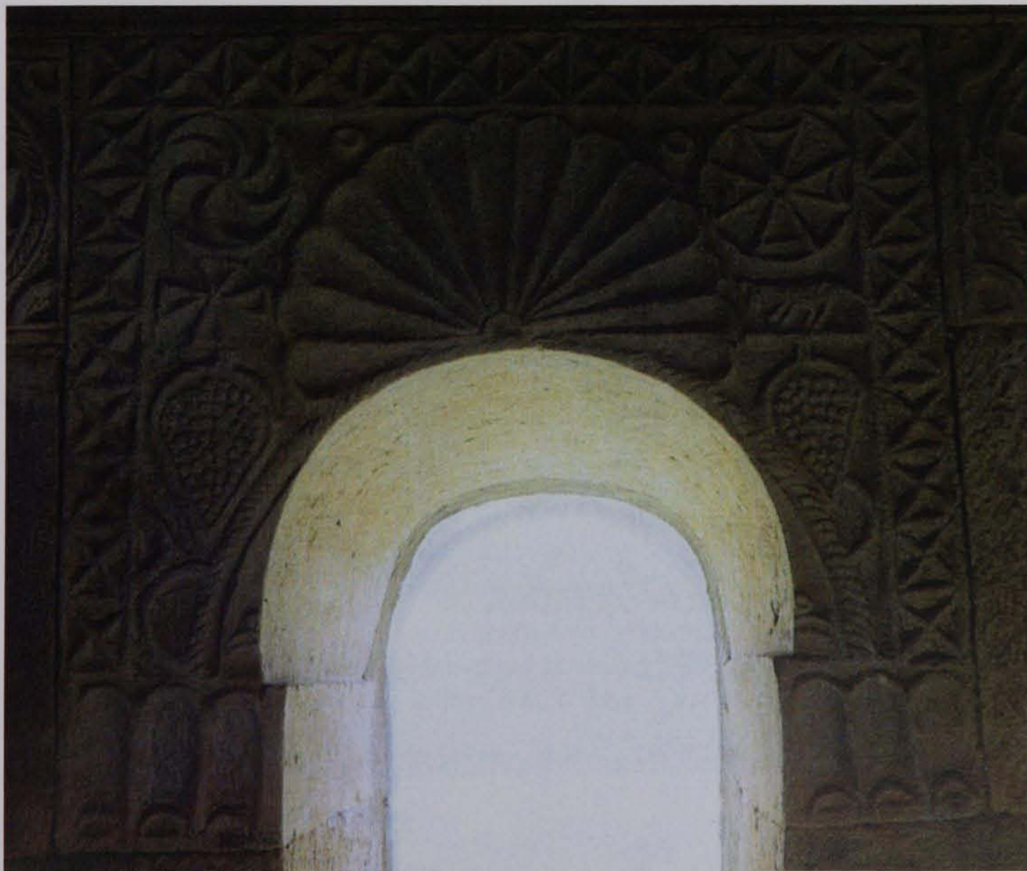
Fig. 298; S. Pedro de la Nave, apse, arcuated lintel (after de Palol Salellas, 1991).
